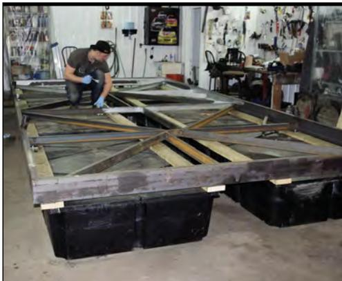
En page couverture, construction d'une section du nouveau brise-lames. Huit unités similaires seront fabriquées par le personnel pour remplacer l'actuel brise-lames et le quai d'accueil. La structure est en métal. Des longerons en bois permettent de fixer les caissons de flottaison.
