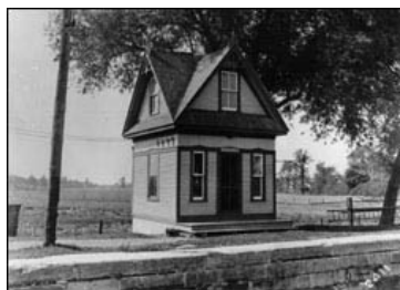
Logette d'éclusier à l'écluse numéro 8, 1934. © Archives nationales du Canada / C-060765
