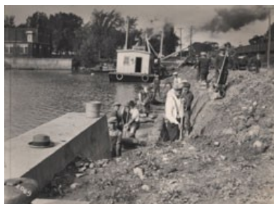
Ouvriers travaillant à la réfection d'un quai à Saint-Jean-sur-Richelieu, en 1931.
